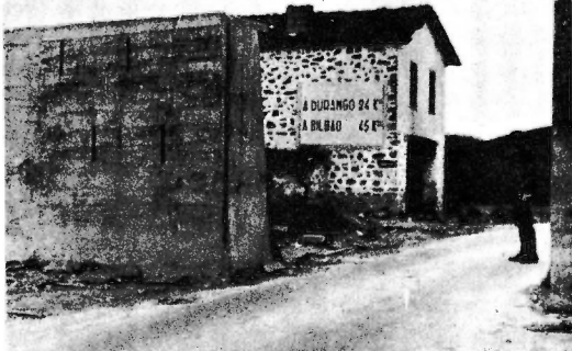
La salida de Ochandiano, protegida por una muralla de hormigón.
